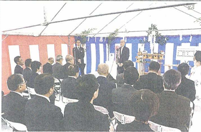
建築学科棟の新設場所で行われた地鎮祭 ＝袋井市豊沢の静岡理工科大
