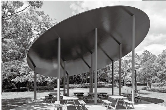
▲屋外空間に大屋根及びテラス・ベンチを設置(2021年3月)
