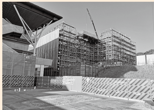
▲土木工学科棟(仮称)の建設状況(昨年12月22日撮影)
