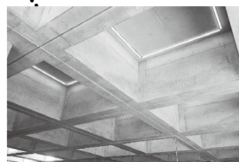
ワッフルスラブ屋根 3つのコンクリートコアと屋根で 建物を支える
